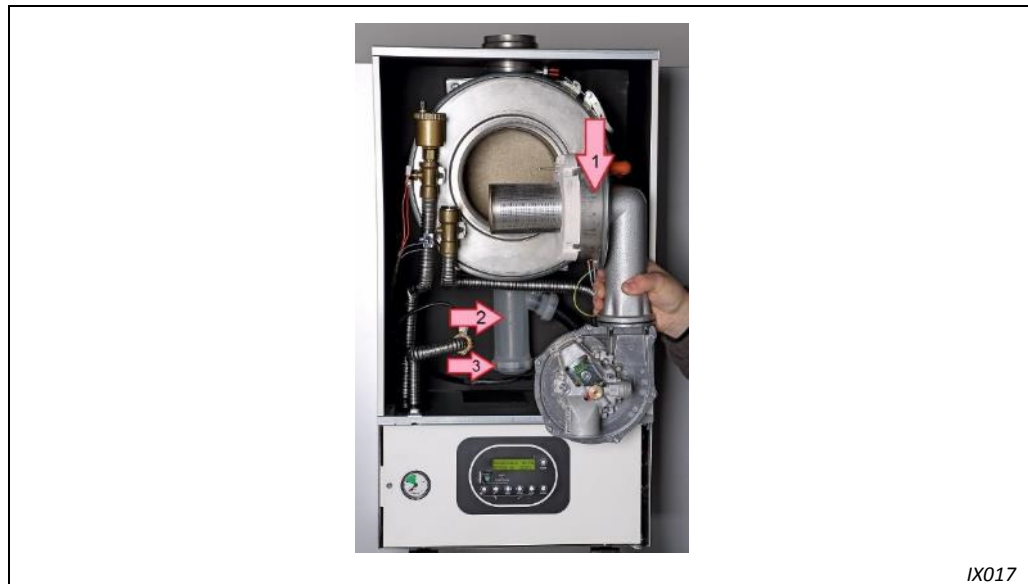
Abbildung 24 Brennermodul ausgebaut und Siphon
