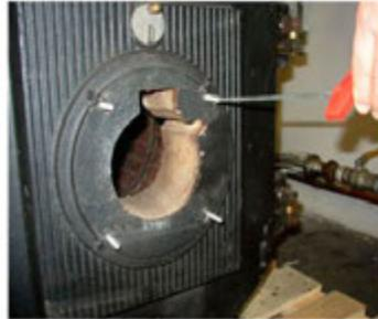
**Einschrauben der Haltebolzen in den Kessel**
