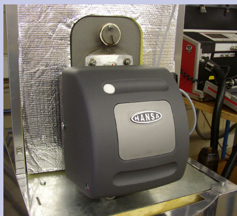
.....nach dem Einbau
