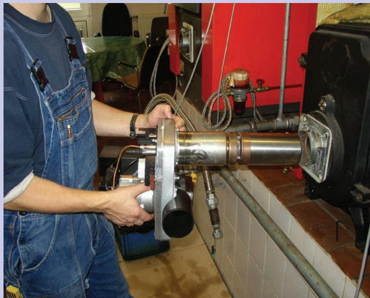
Der Brenner wird durch den Schiebeflansch in den Kessel eingeführt
