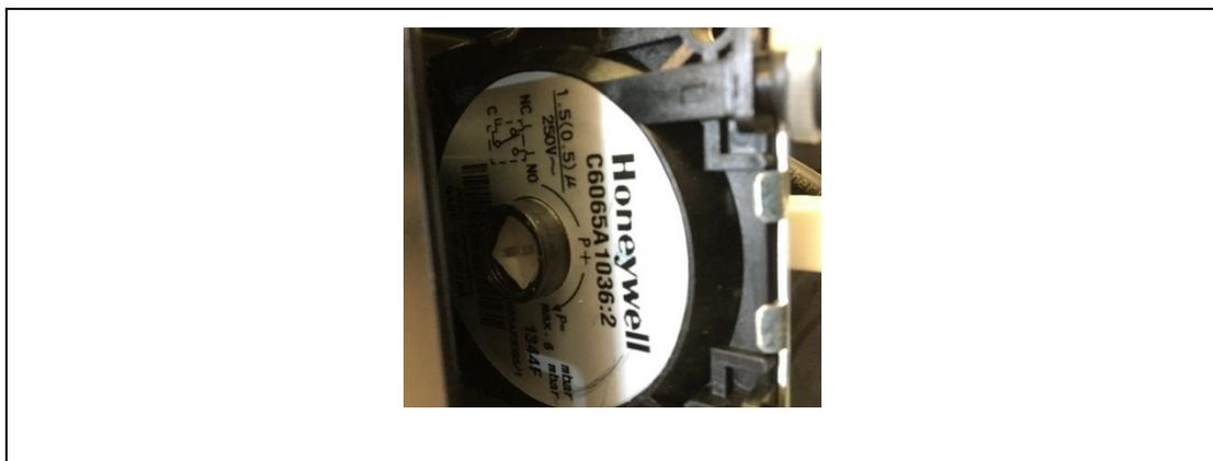
Abb. 8: Luftdruckschalter ist ab Werk eingestellt, muss aber im Einzelfall auf die Druckbedingungen der Anlagen angepasst werden. Drehrichtung P+ = Schaltpunkt bei höherem Luftdruck
