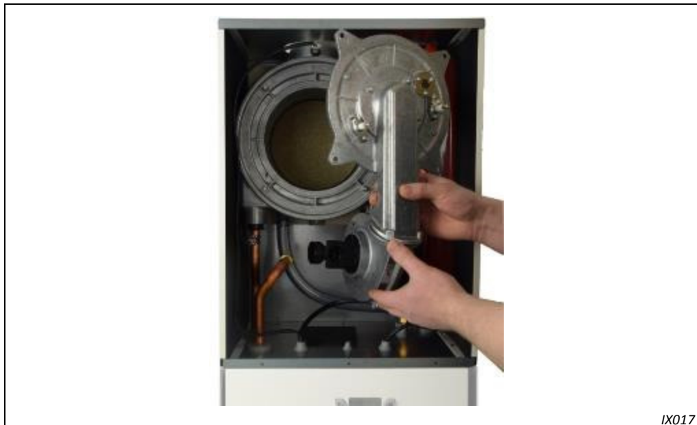
Abb. 26: Brennermischvorrichtung herausnehmen, O-Ring beachten.
